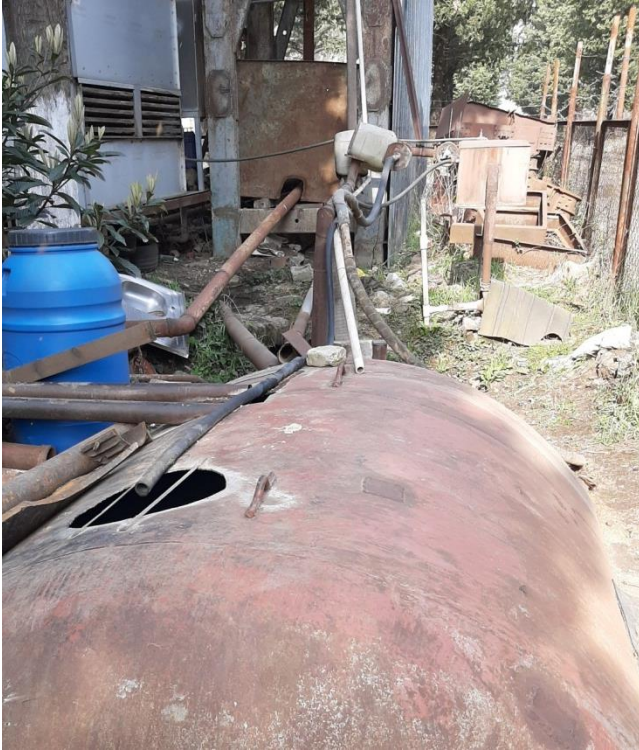
სურათი 3. შხეფსაცივარი და ლიცენზირებული ჭაბურღილი საწარმოო შენობის ჩრდილო-აღმოსავლეთით, შპს „კავკასია 2007“-ს არასასოფლო-სამეურნეო მიწის ნაკვეთზე (ნაკვეთის კოდი 03.05.01.922) მდებარეობს ადმინისტრაციული შენობა (სურათი 4) და სკვერი (სურათი 5).
